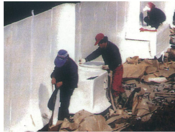
▲ 지하외벽의 방수층 보호재 Protection for Bitucine Coating Surface of Underground Construction Layer
