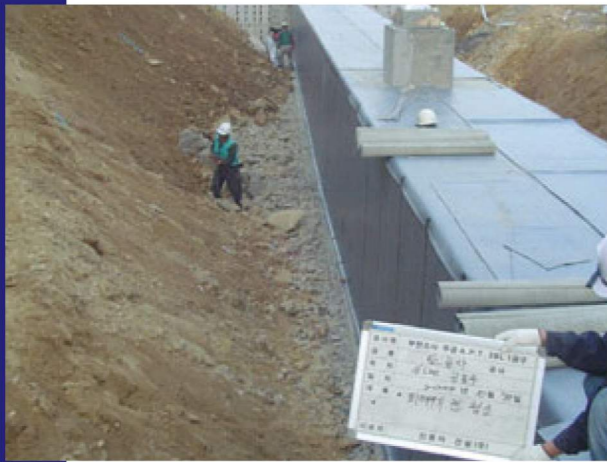
▲ 지하외벽의 방수층 보호재 Protection for Bitucine Coating Surface of Underground Construction Layer
